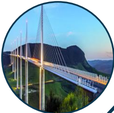
Viaduc de Millau
