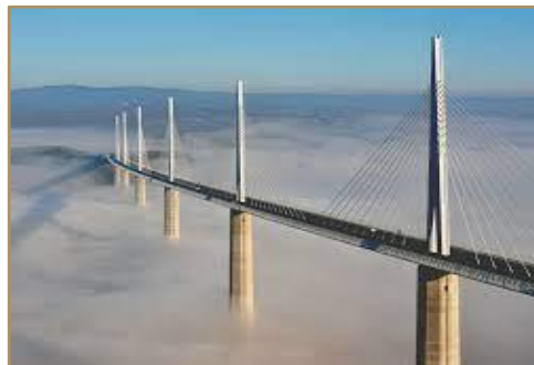
Viaduc de Millau
