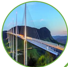
Viaduc de Millau
