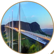
Viaduc de Millau
